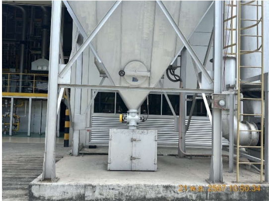
ถังเหล็กเก็บฝุ่นอะลูมิเนียม จากระบบดักฝุ่นแบบถุงกรอง
