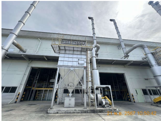
รูปถ่ายที่ 3.2-1 : ระบบดักฝุ่นแบบถุกรอง
