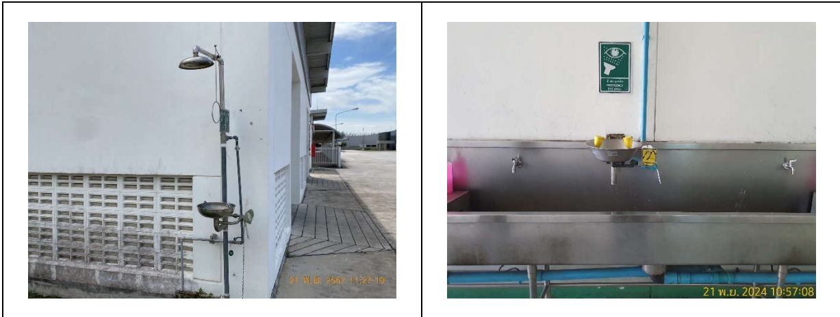
รูปถ่ายที่ 3.2-38 : ฝักบัวฉุกเฉินและอ่างล้างตา
