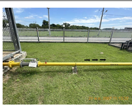
รูปถ่ายที่ 3.2-48 : ป้ายแสดงทิศทางการหมุนวาล์ว และแสดงทิศทางการไหลในท่อขนส่ง
