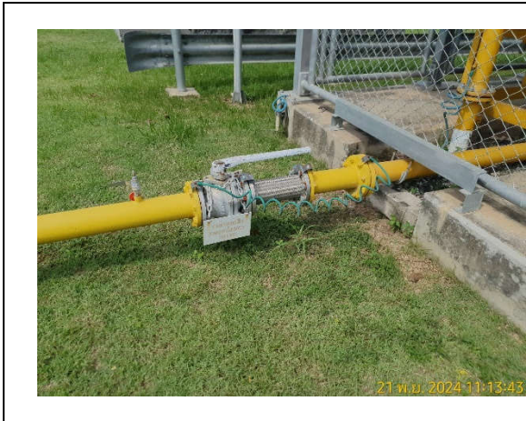
รูปถ่ายที่ 3.2-48 : ป้ายแสดงทิศทางการหมุนวาล์ว และแสดงทิศทางการไหลในท่อขนส่ง
